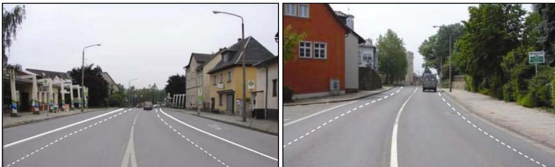
**Abb. 17:** Beispiele für kurzfristige Maßnahmen – Markierung von Schutzstreifen
